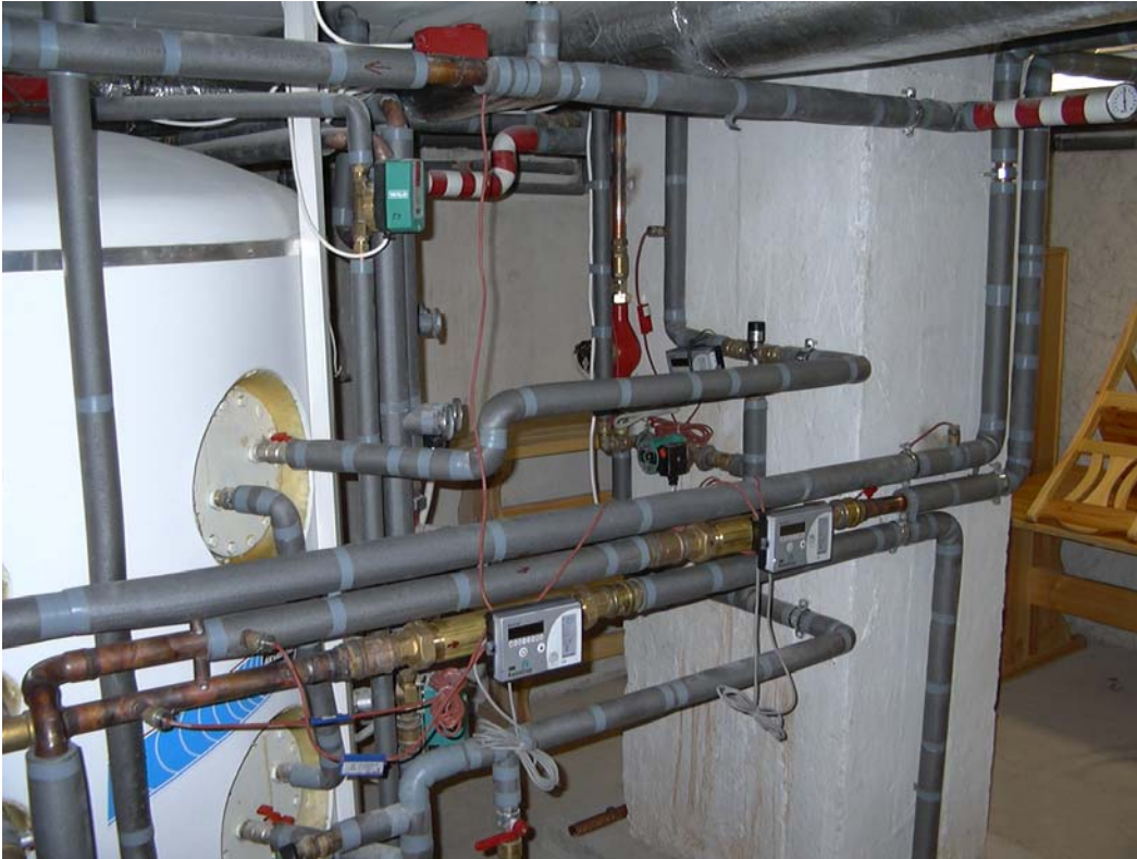
Joonis 6. Paigaldatud soojusmõõturid
