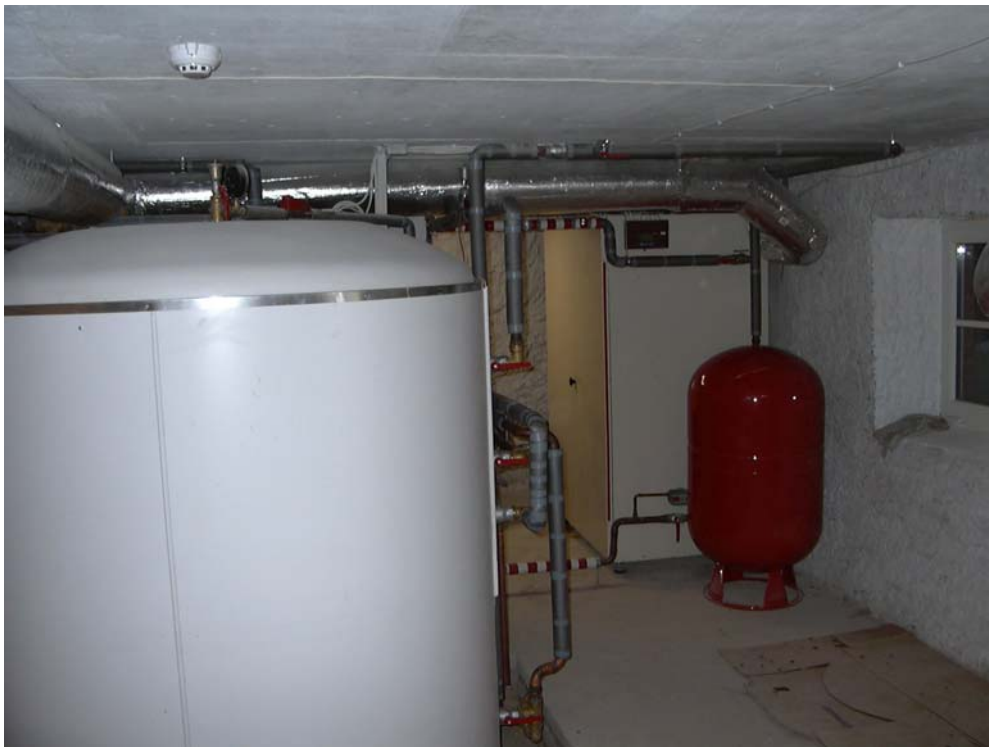
Joonis 3 Soojuspump (taamal paremas nurgas) koos veemahuti ja paisupaagiga
